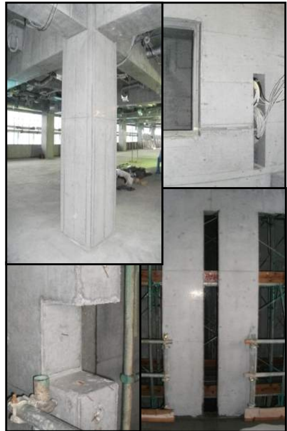
写真-1 構造体コンクリートの狭隙部への打込み状況
