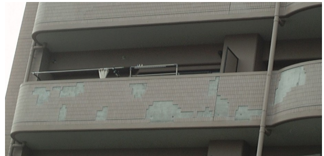
写真－1 タイル剥落の実例
