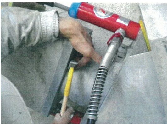
(7) くさびによる鋼管止め状況
