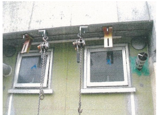
(4) 上部仮設金物状況
