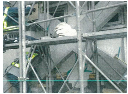
(6) 四隅型枠状況
