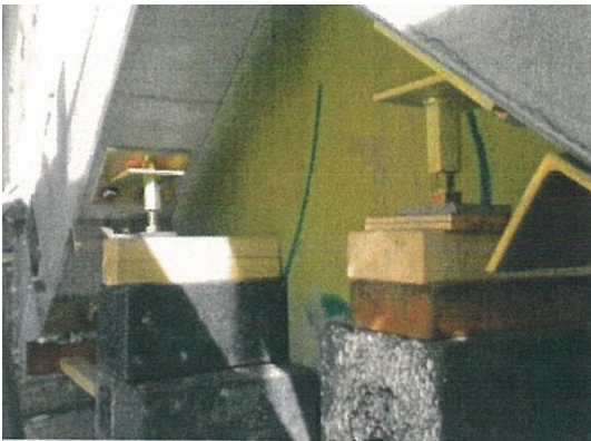
(5) 下部仮設支持部状況
