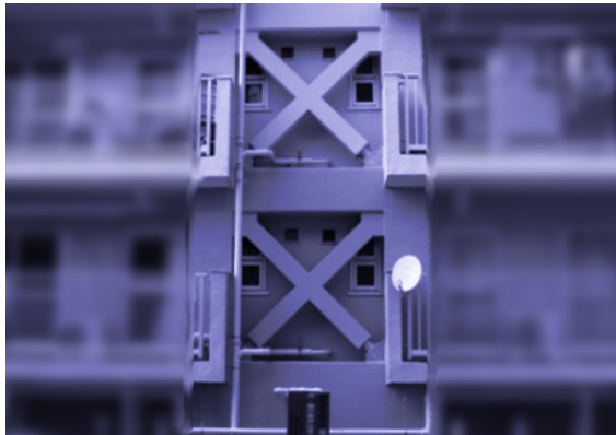
写真-2 仕上げ状況
