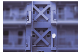
写真ー1 補強スパン
