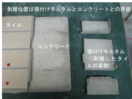
写真-1 剥離したタイル（105℃で乾燥、8日目）
