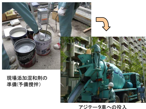
写真-1 現場添加混和剤の攪拌・投入
