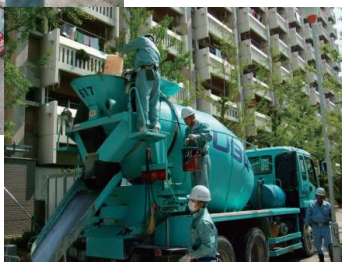
アジテータ車への投入
