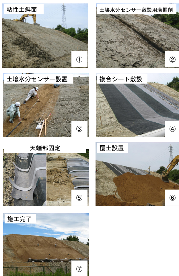
写真-5 斜面適用性実験状況
