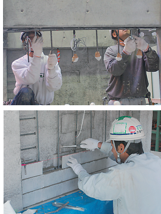
写真－2 試験体製作状況
