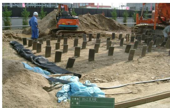
写真-2 PBD打設完了後の状況
