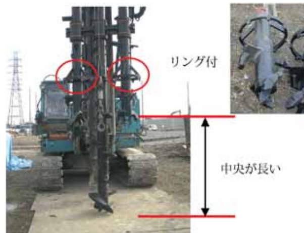
写真-1 施工機械（三軸オーガーマシン）
