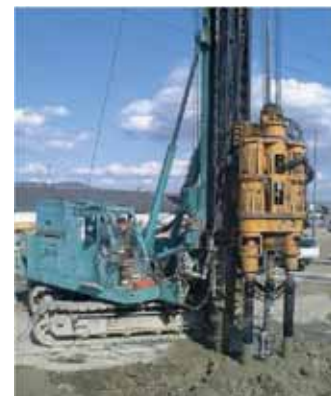
写真－ 2 施工状況
