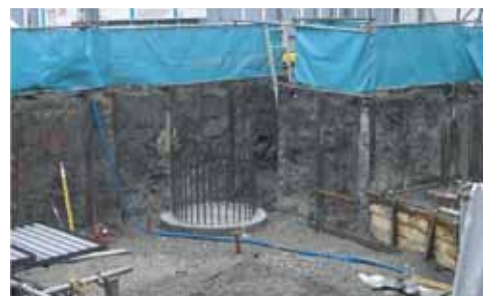
写真－4 大阪市内の作業所における施工（掘削完了時の状況）
