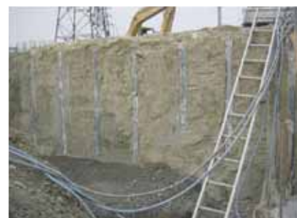
写真－ 3 掘削完了時の状況
