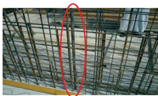
写真－６ 太径異形鉄筋挿入状況（立面）
