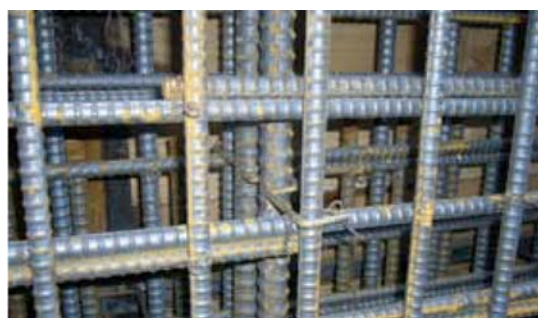
写真-2 誘発目地部の太径異形鉄筋挿入状況
