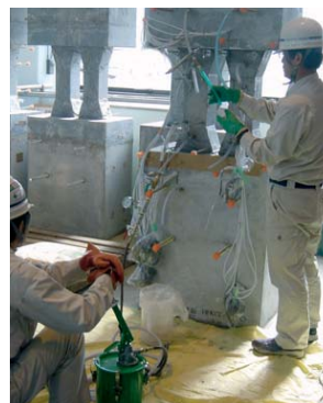
写真－3 注入ホースによる樹脂注入施工状況
