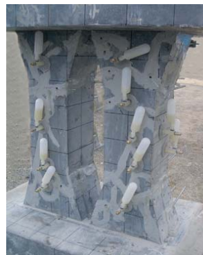
写真－1 樹脂低圧注入工法
