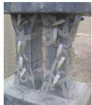
(a) 注入ホースによるエポキシ樹脂注入工法 (b) エポキシ樹脂低圧注入工法
