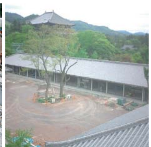
写真-7 屋根瓦葺完了
