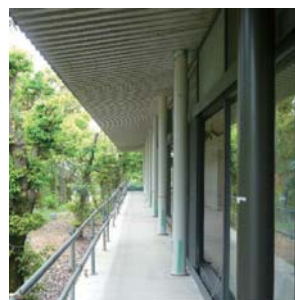
写真-8 軒先状況
