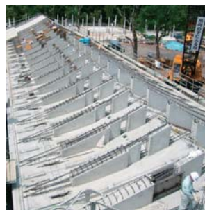
写真-6 PCaRC版据付
