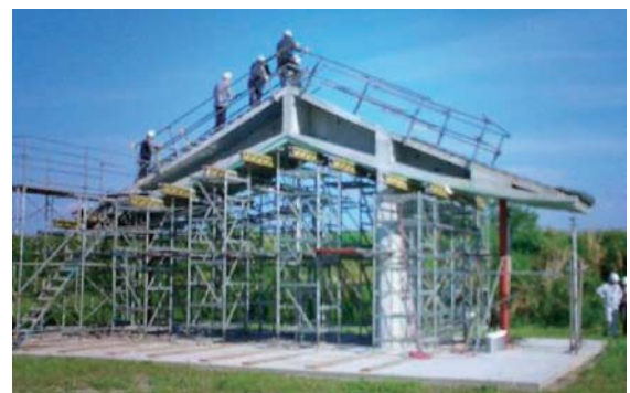
写真-5 モックアップ試験体による施工実験
