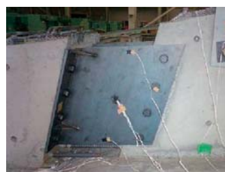
写真-1 追加された梁部補強版
