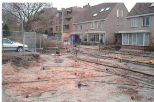
写真－2 Zeistでの浄化状況
