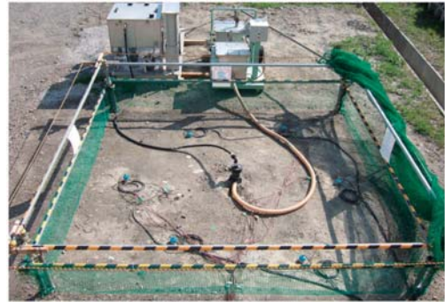
写真－3 実証実験状況
