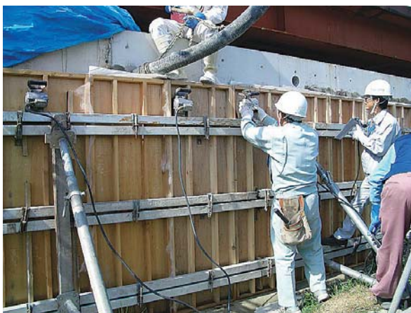
写真－３ 実大壁試験体の打設
