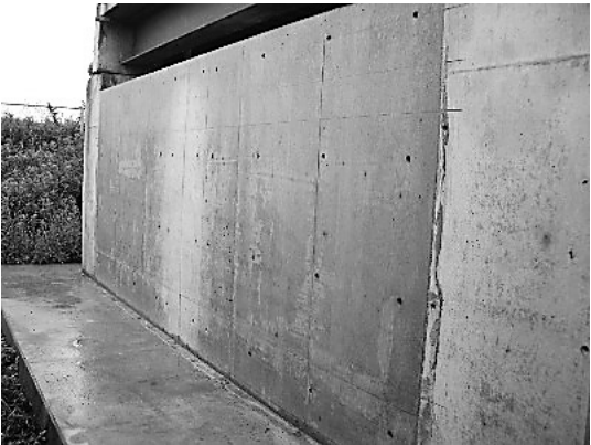
写真－１ 実大壁体（東側）
