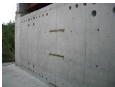
【コア抜き状況】
