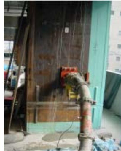
写真-1 CFT 柱への圧入
