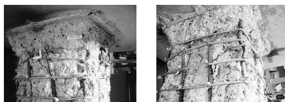
写真－２ 鋼板除去後の柱頭部の状況
