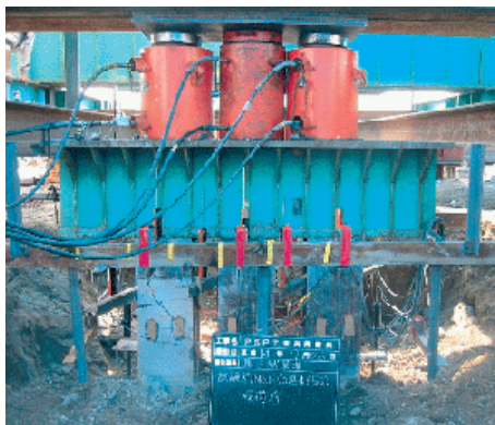
写真－3 載荷試験
