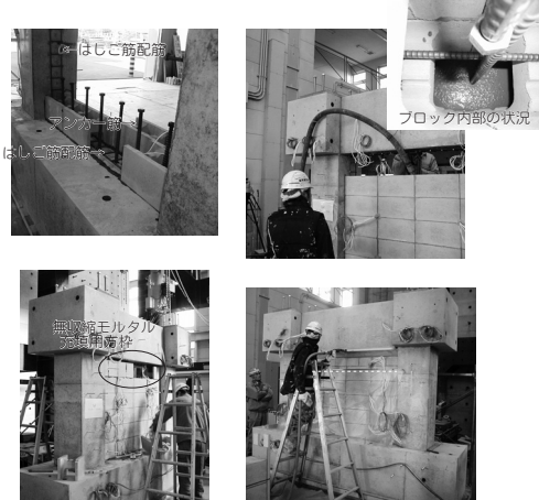
写真－２ 施工状況
