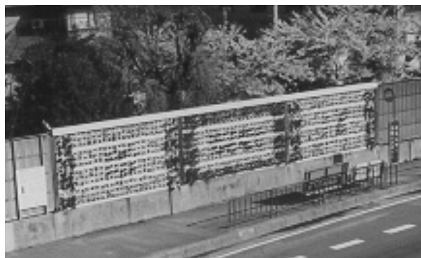
写真-1 設置直後の植栽状況
