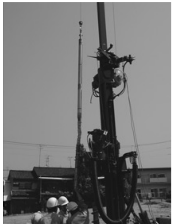
写真－３ プローブ挿入状況
