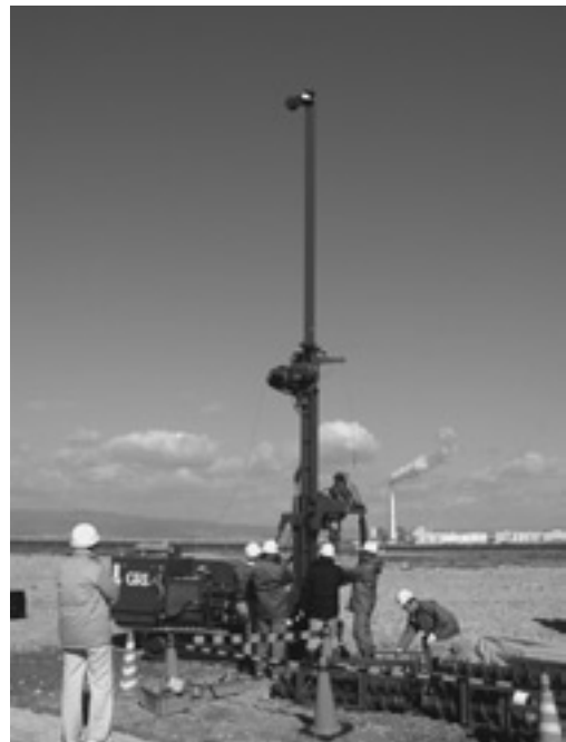
写真－１ 掘削機械全景
