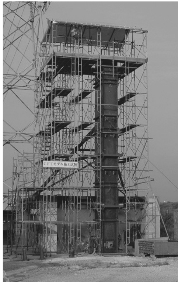
写真－1 モデル施工試験 試験体
