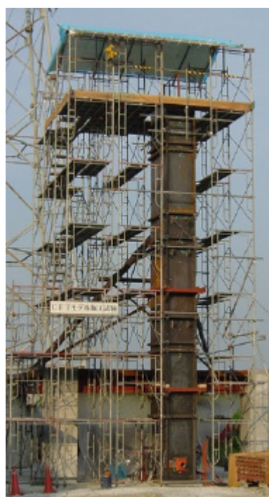
モデル施工試験体
