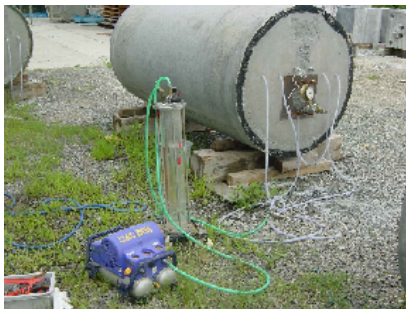
写真-1 注水試験状況
