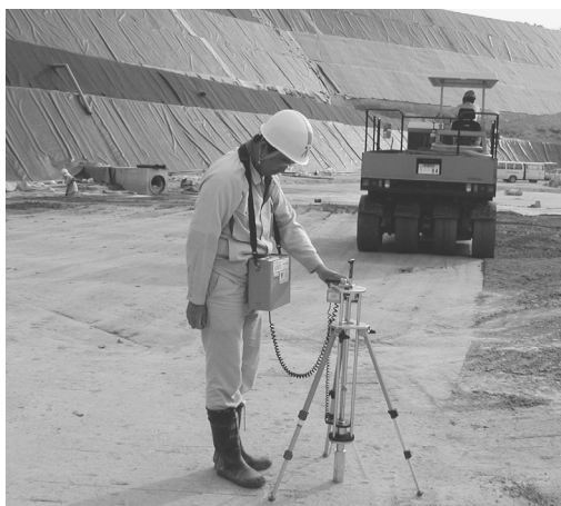
写真－３ キャスボルによる測定状況
