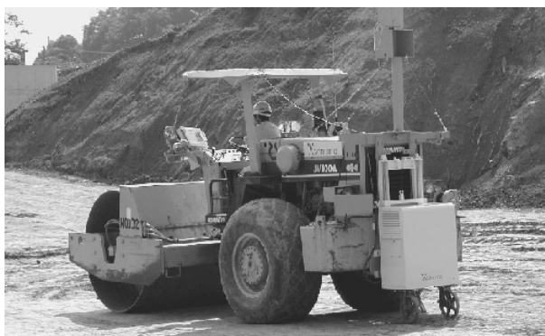
写真－5 試験施工状況
