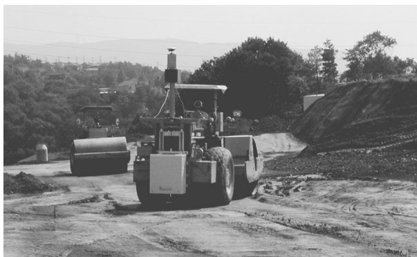
写真－6 試験施工状況
