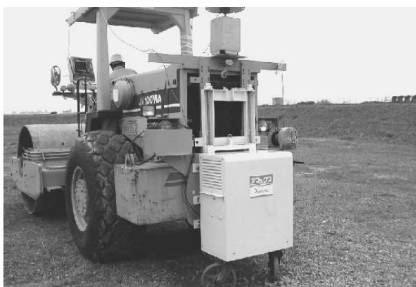
写真-1 アマックス取り付け状況
