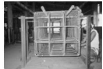
写真－１ 帯筋の先組み状況 (囲型試験体)
