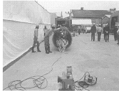
写真-4 ライニング材引き込み状況
