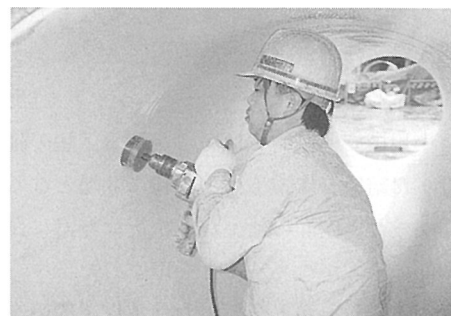
写真-7 逆止弁取付状況
