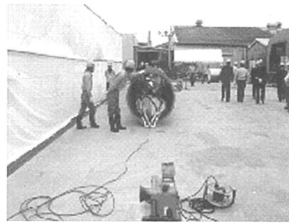
写真-4 ライニング材引き込み状況
