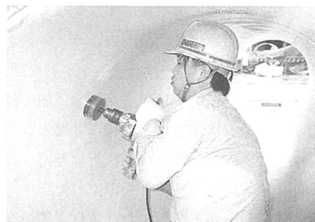
写真-7 逆止弁取付状況
