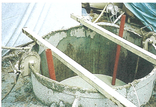
写真-1 ガイドパイプの取付け
