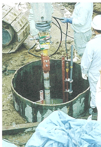
写真-3 超遅延剤の混入状況
