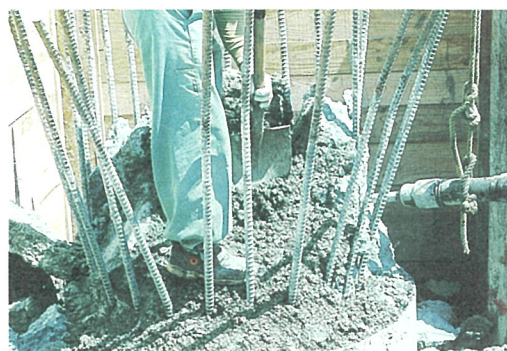
写真-4 杭頭処理状況
