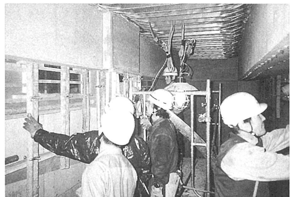
〔分離打設状況〕
