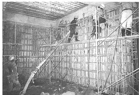
〔連続打設状況〕
