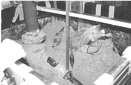
写真-4 管変位の実測状況
