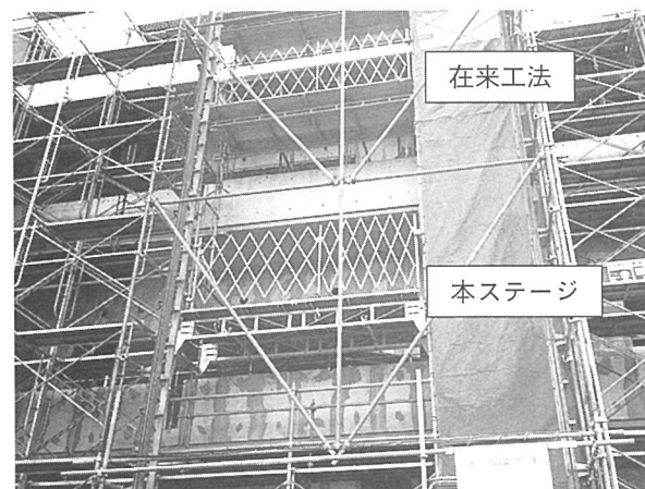
写真-3 ステージ設置状況（設置終了）
