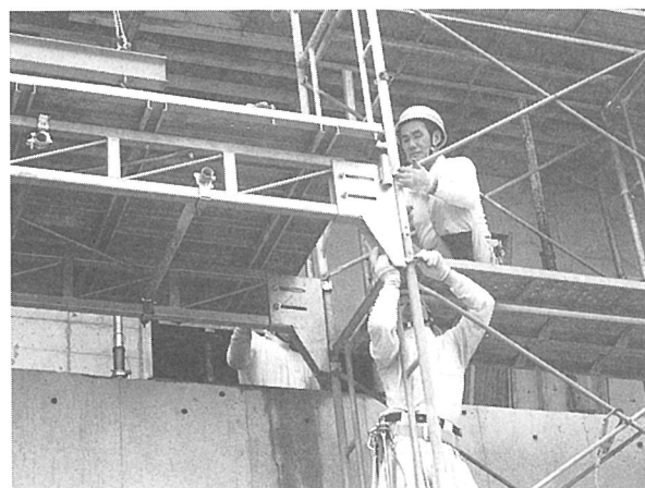
写真-2 ステージ設置状況（足場への取り付け）
