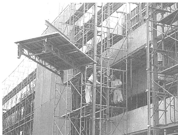
写真-1 ステージ設置状況（揚重状況）
