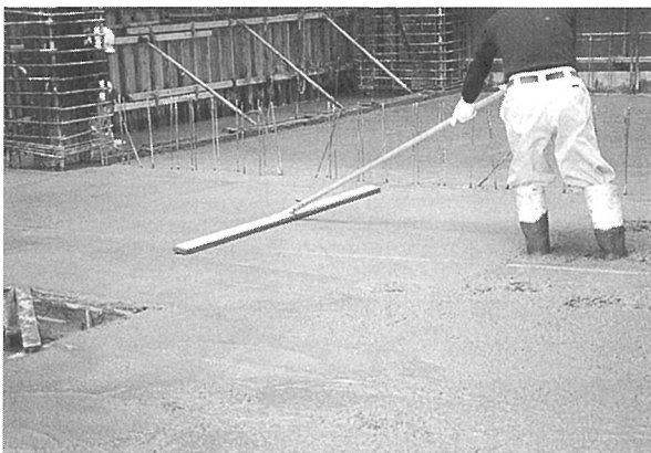
写真-4 定規ずり均し作業状況
