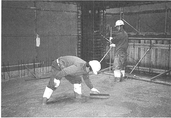
写真-3 レベル調整作業状況
