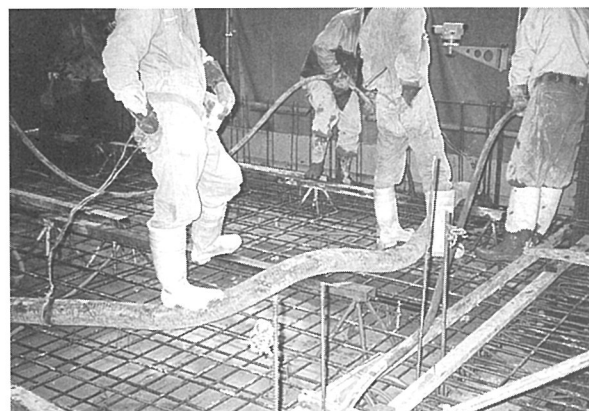
写真-2 コンクリート打設状況
