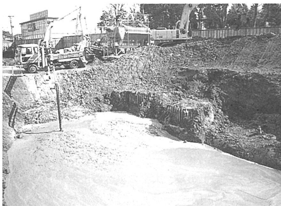
写真-3 気泡モルタルの製造・打設
