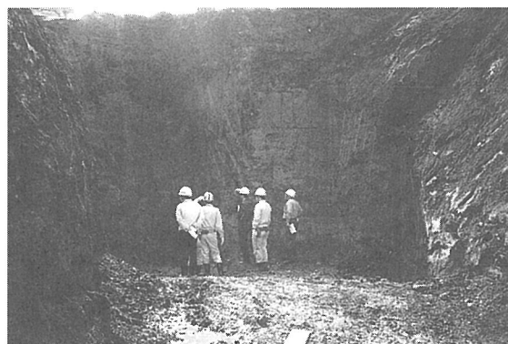
写真-1 掘削による露出地盤の検査
