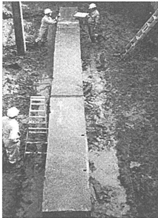
写真-2 試験壁の掘出し状況 (GL-7.0m)
