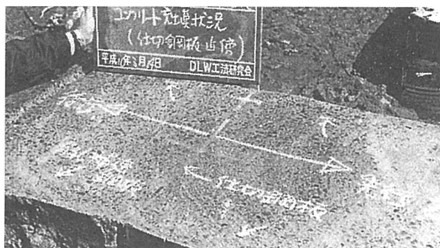
写真-3 壁間継手部断面
