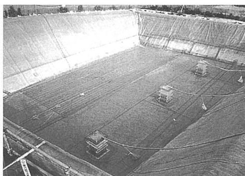
写真－2 実大実証実験の全景
