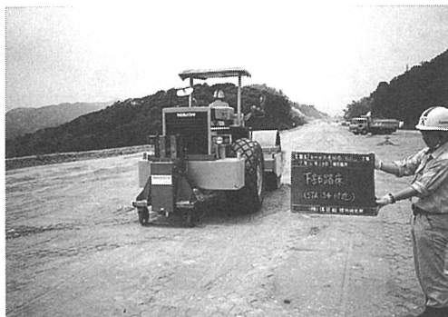
写真-3 本システムによる盛土の施工状況
