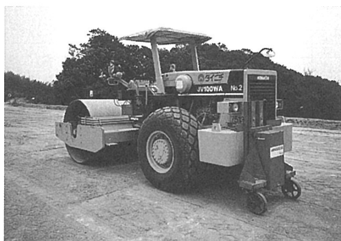
写真-2 管理装置の取付け状況
