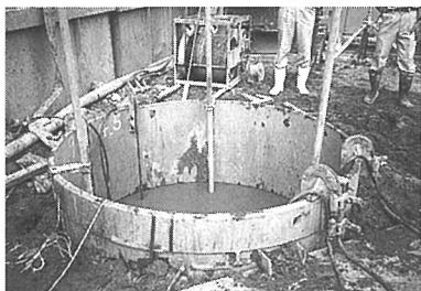
写真-2 引上げ用パイプの固定
