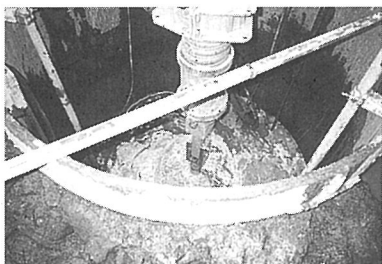
写真-3 攪拌状況
