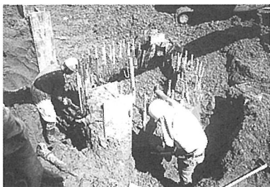
写真-5 No.1 杭のハツリ作業状況
