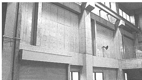
写真－2 ③通壁の竣工後の状況
