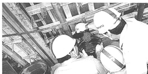
写真－1 流動試料採取の状況
