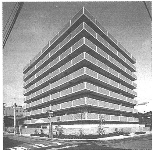
写真-1 建物外観
