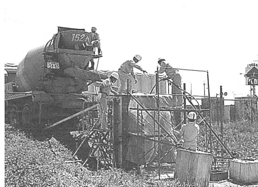
写真-5 コンクリート打設 (Type-1)
