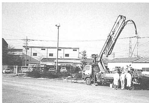
写真ー 3 圧送試験の状況
