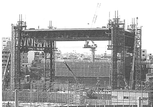
写真-1 リフトアップ完了時
