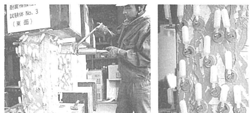
写真－1 エポキシ樹脂注入
