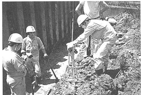
写真-2 測定状況（国道8号線）
