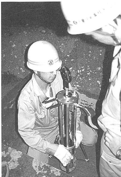
写真-1 測定状況（国道24号線）
