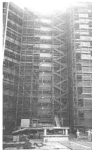
写真－４ シュートの取付け完了
