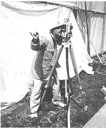
写真－２ トータルステーションを用いた測量状況
